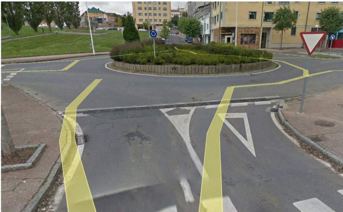
Estado actual da rotonda coa reixa e sumidoiro de tragadeira
