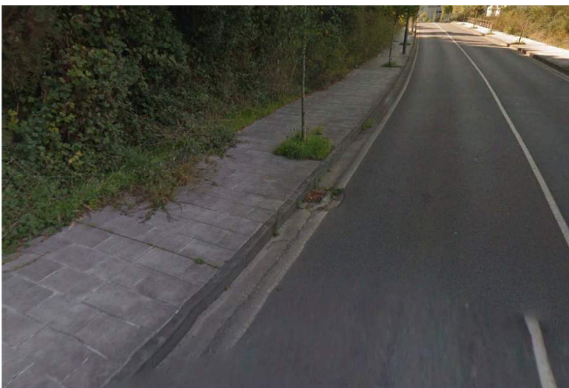
Estado das reixas na actualidade
